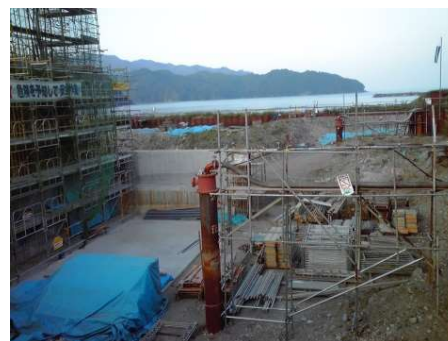
② 河口部でのドライワーク（水替工） （岩手県釜石地方振興局発注、農地海岸下荒川地区第14号（水門土木）工事、平成21年～23年）
