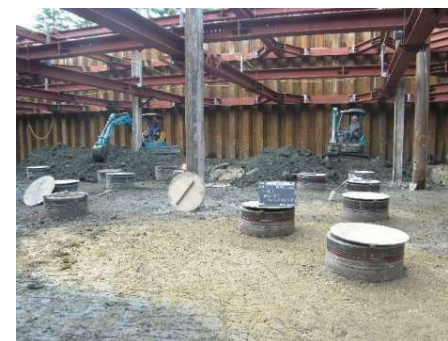
③ 盤ぶくれ対策、復水（日本下水道事業団発注、市川市菅野下水処理場建設工事、平成25年）
