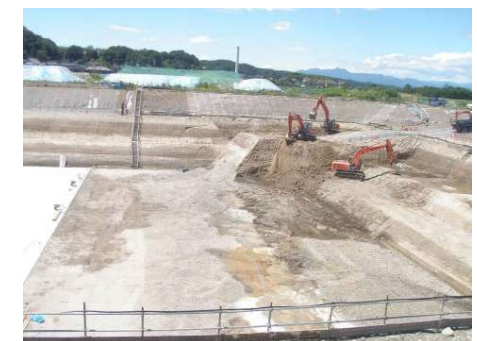
④ 開削工事のドライワーク（東京都下水道局発注、八王子水再生センター西系水処理施設建設工事、平成26年～29年）
