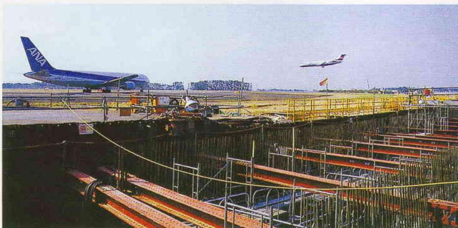
掘削区間から滑走路の方向を見る。航空機の離着陸の障害にならないようアクセス鉄道は、滑走路の端部を通る342mがトンネル、その前後の区間が掘削構造になった
