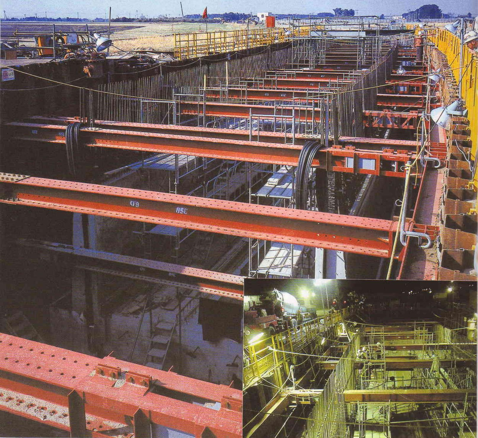
宮城県名取市と岩沼市にまたがる仙台空港。同空港へのアクセス鉄道のトンネル工事で、くみ上げた地下水を空気に触れることなく地中に戻す真空プレス型リチャージウエル工法と呼ぶ方法を採用している。地下水は鉄分を含み、空気に触れると赤く変色するからだ。地中に戻すことで地盤沈下を防止する効果もある。1日の処理量は約7300m<sup>3</sup>。これだけの大規模な施工例は初めてだ。
