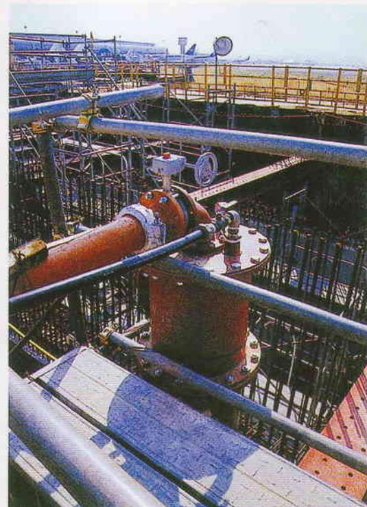
揚水井戸の上部。復水井戸との間には圧力ポンプのほか、水とともに吸い上げた砂などをためる密閉式のタンクが設置してある
