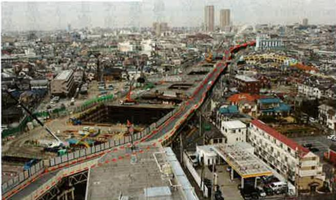
写真1 市街地を横過する工事専用道路(仮橋)
