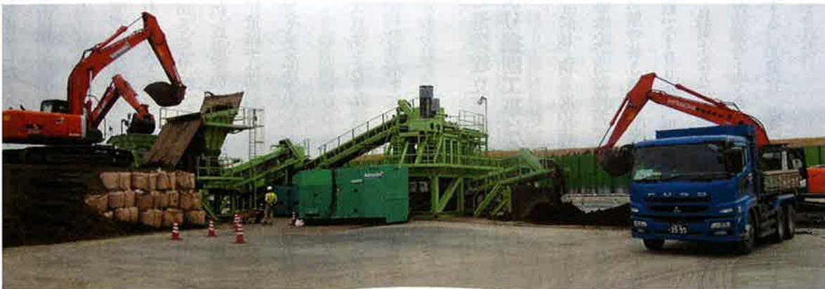
写真3 仮置きヤードにおいて浅場造成に適した改良土を製造
