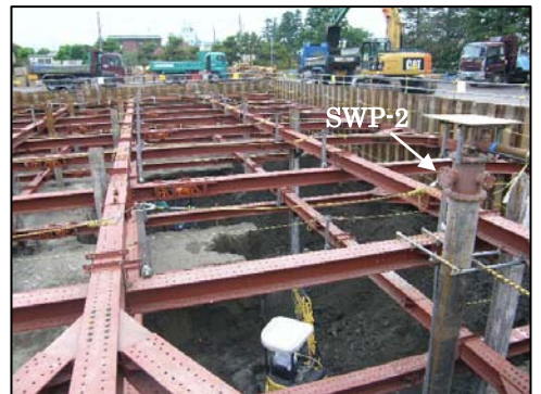
写真 1 掘削状況（ドライワーク）
