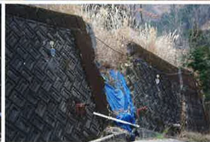
上/有瀬地区の全景。下左/地すべりで壊れた道路。下右/亀裂の入った壁。
