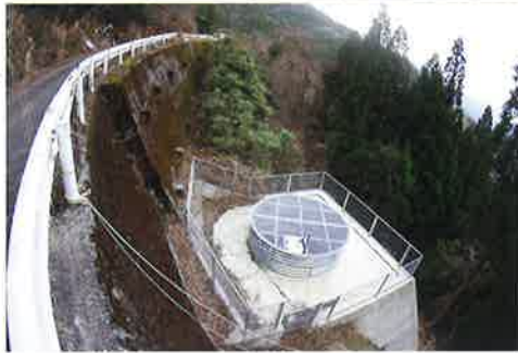
上/排水トンネルの入口。下/集水井。
