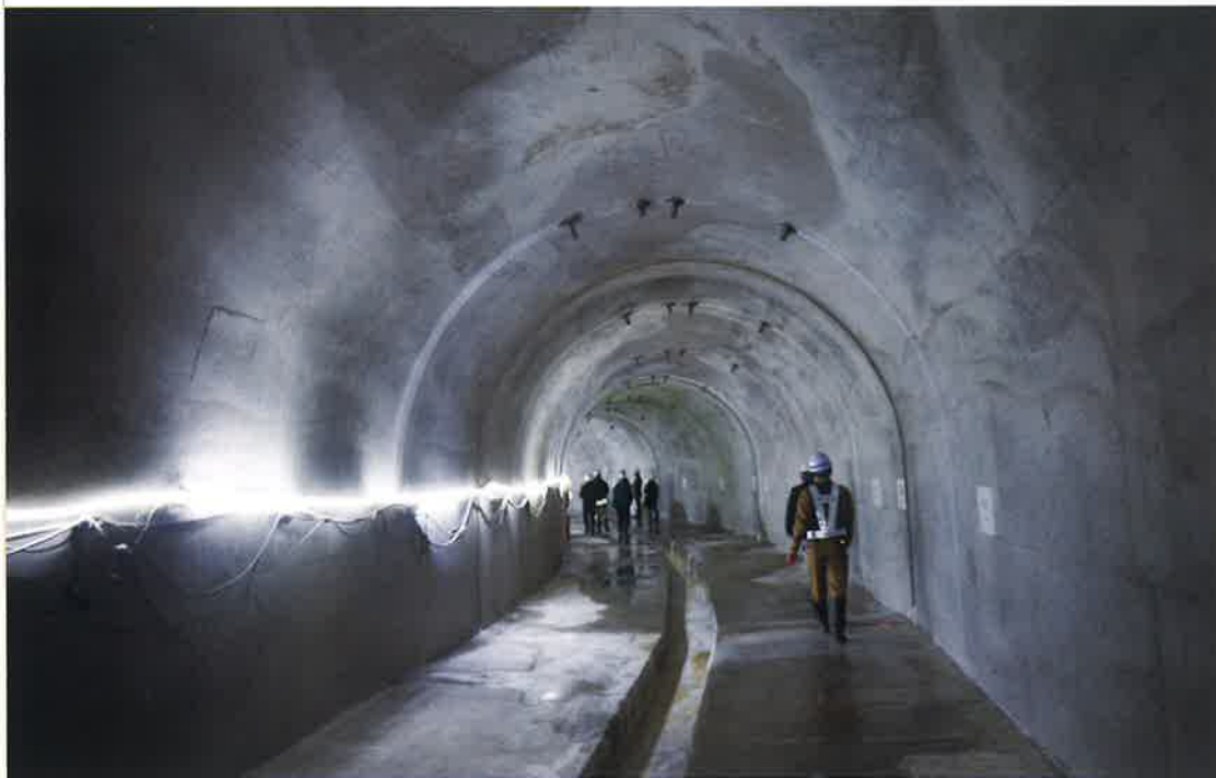
排水トンネル内部。
