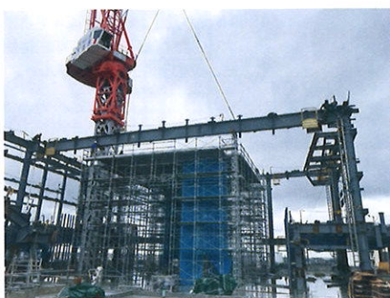
議場の大空間鉄骨梁建方状況
