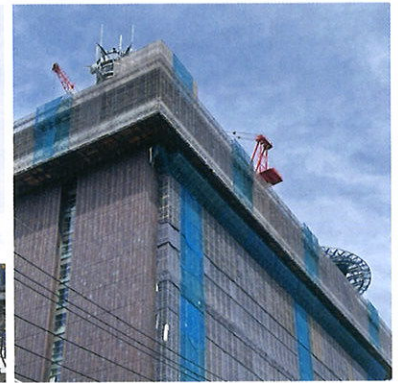
20階展望フロア部特殊吊足場・外部足場設置状況
