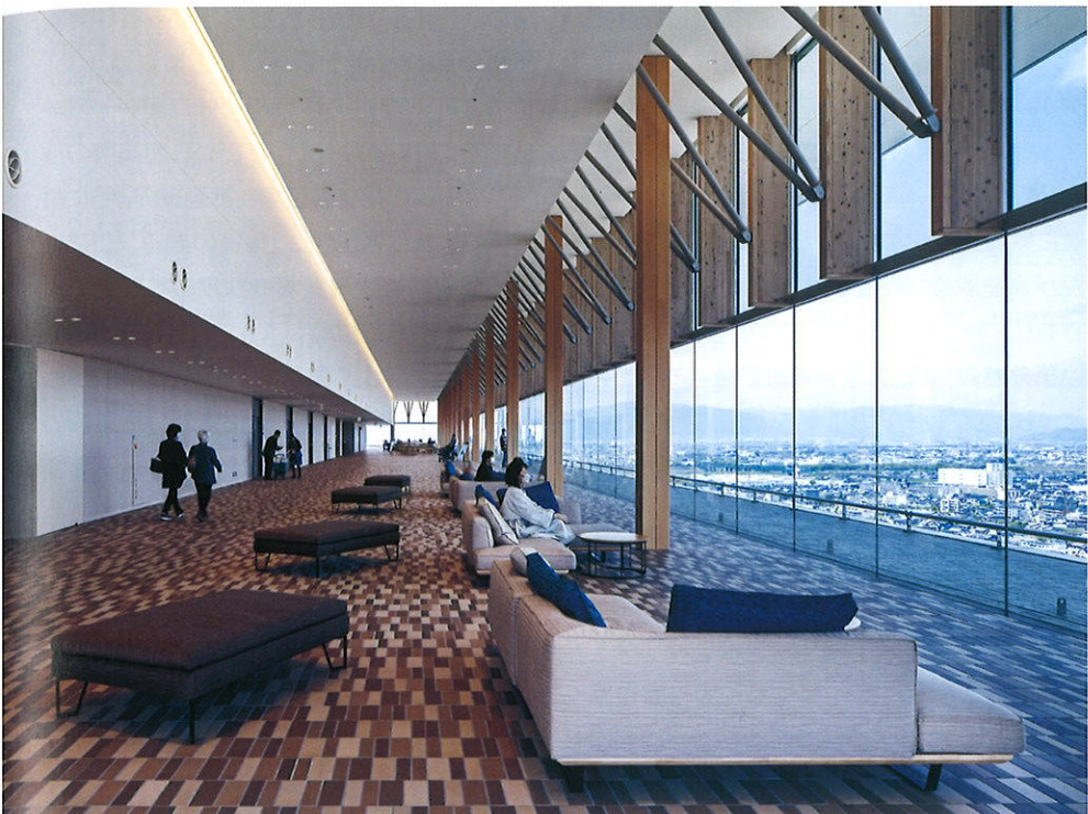
左/岐阜の景色を一望できる清流ロビー 右上/景色を遮らない県産スギCLTを利用した大開口木鋼ハイブリッドサッシ 右下/旧庁舎から移設された矢橋六郎氏作のモザイク壁画
