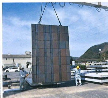
外壁PC版の工場（還元焼成）確認
