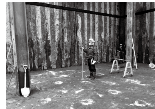
④床付け検査状況
