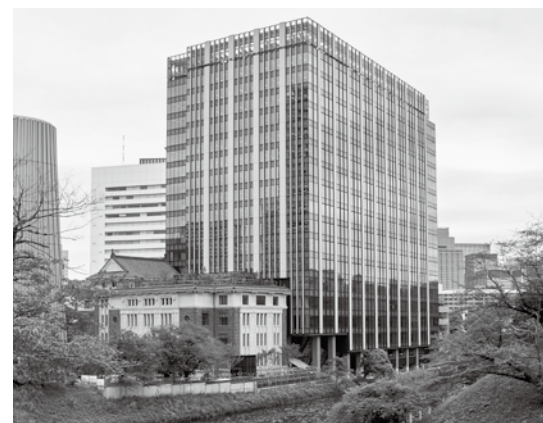
①牛ヶ淵際建つ増築棟
