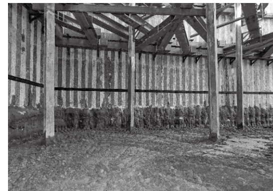
③4次掘削施工状況(砂質土層・粘性土層切り替り)
