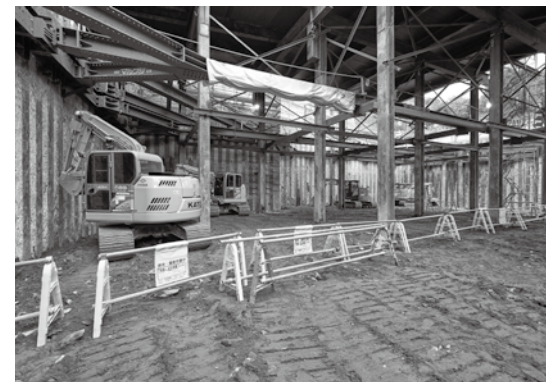
②2次掘削施工状況(砂質土層)
