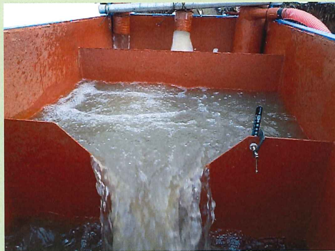
ポンプ稼働状況
