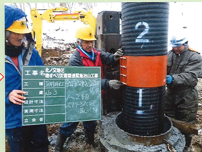
スクリーン管挿入
