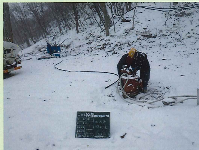
揚水設備設置
