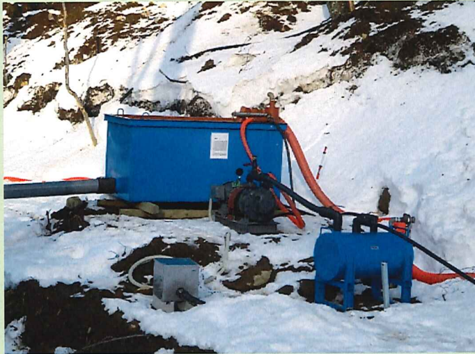
ポンプ、ノッチタンク設置
