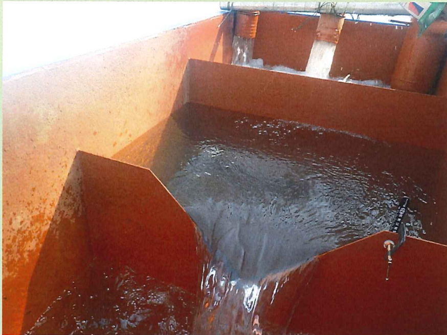
スーパーウェルポイント工法の排水状況
