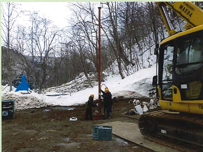
揚水管建込み
