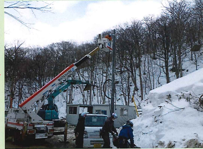
電柱建柱、キュービクル設置
